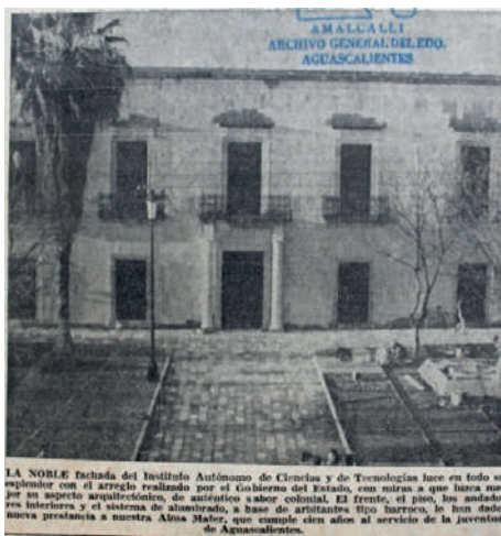
Imagen 33. Fachada del IACT después de su restauración. Fuente: El Heraldo de Aguascalientes , 14 de enero de 1967, Segunda sección, 1.
