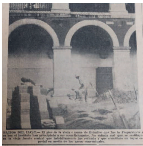
Imagen 32. Patio del IACT durante los trabajos de remodelación. Fuente: El Heraldo de Aguascalientes , 5 de noviembre de 1966, Segunda sección, 1.
